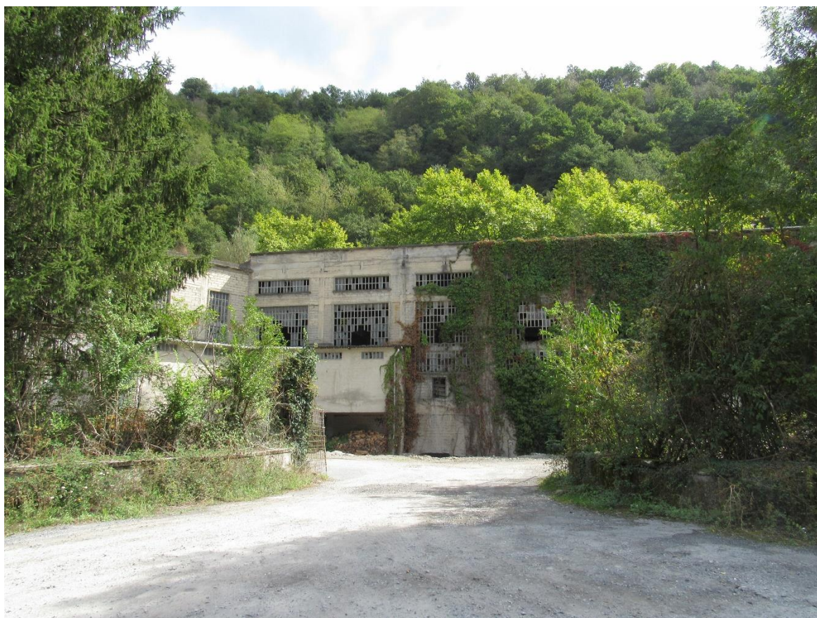
Imagen 3. Edificios en desuso en margen izquierda del río Araxes. Foto: Ekolur.
