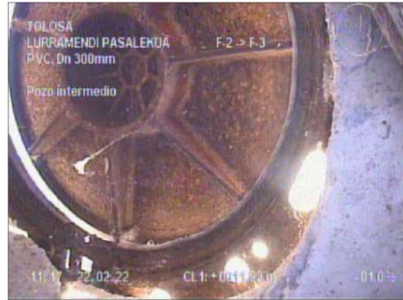
Fotografía: 4_2b 11,9m, Pozo intermedio
