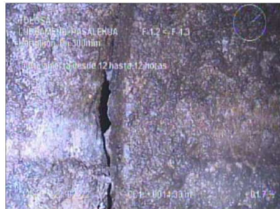
Fotografía: 9_3b 14,3m, Junta abierta desde 12 hasta 12 horas
