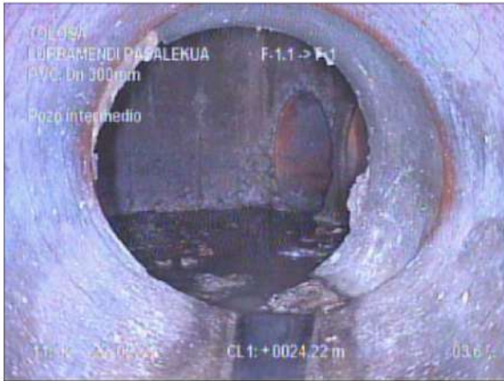
Fotografía: 6_2a 24,9m, Pozo intermedio
