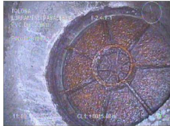
Fotografía: 2_2b 15,5m, Pozo intermedio
