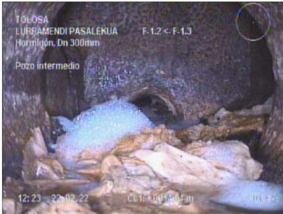
Fotografía: 10_4a 15,5m, Pozo intermedio
