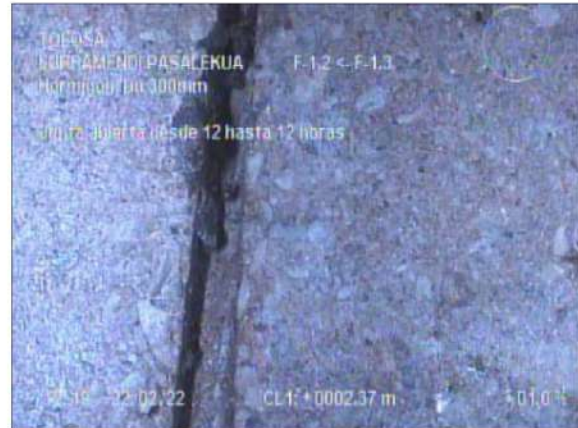
Fotografía: 8_2b 2,3m, Junta abierta desde 12 hasta 12 horas
