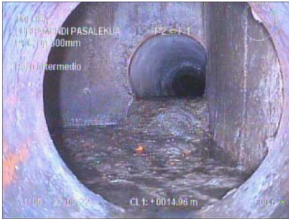
Fotografía: 2_2a 15,5m, Pozo intermedio
