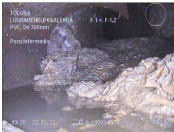
Fotografía: 13_3a 2,9m, Pozo intermedio
