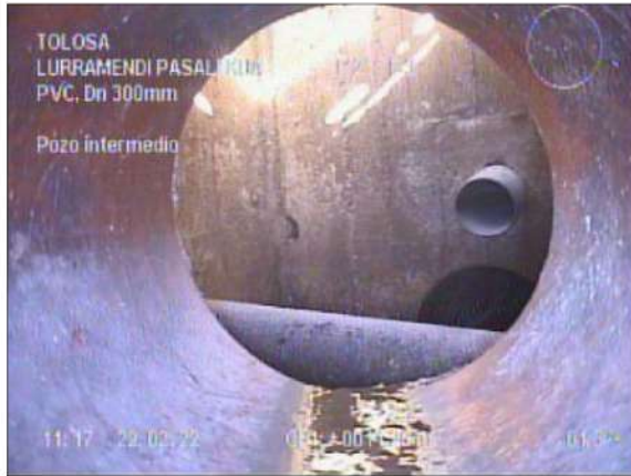
Fotografía: 4_2a 11,9m, Pozo intermedio
