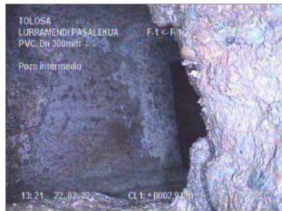
Fotografía: 13_3b 2,9m, Pozo intermedio
