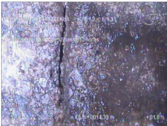
Fotografía: 9_3a 14,3m, Junta abierta desde 12 hasta 12 horas
