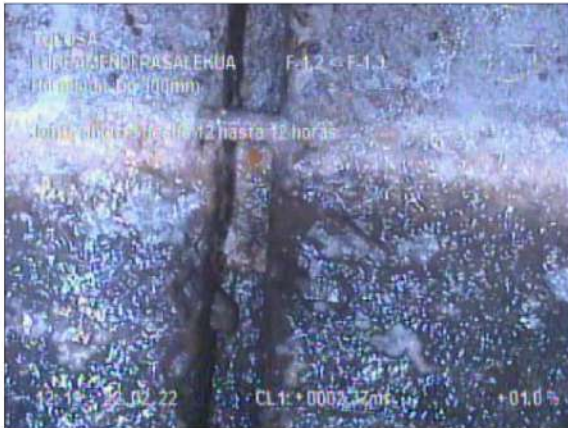
Fotografía: 8_2a 2,3m, Junta abierta desde 12 hasta 12 horas
